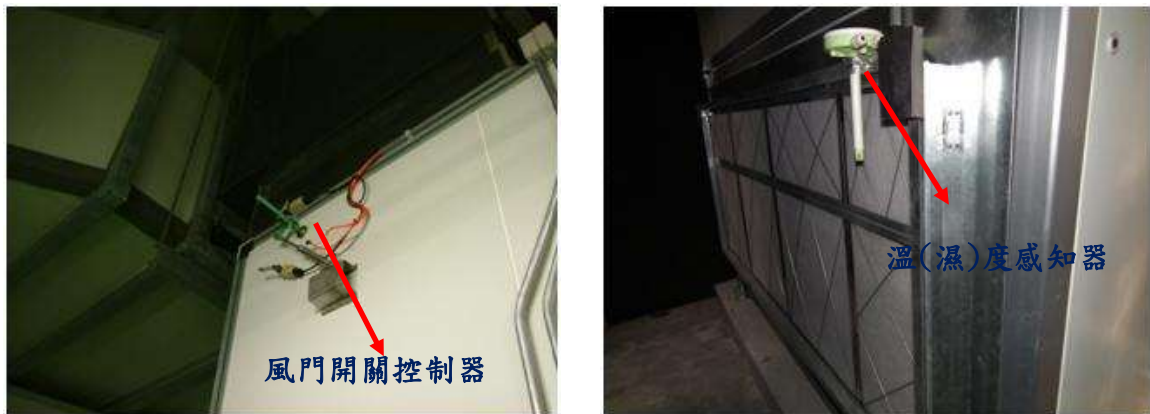
圖 36 空調控制與感知裝置的檢修與維護
