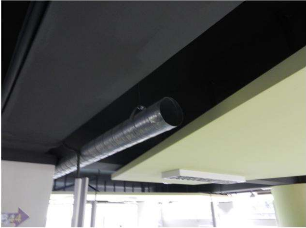
圖 10 外氣輸送風管之出風口不具有風門
