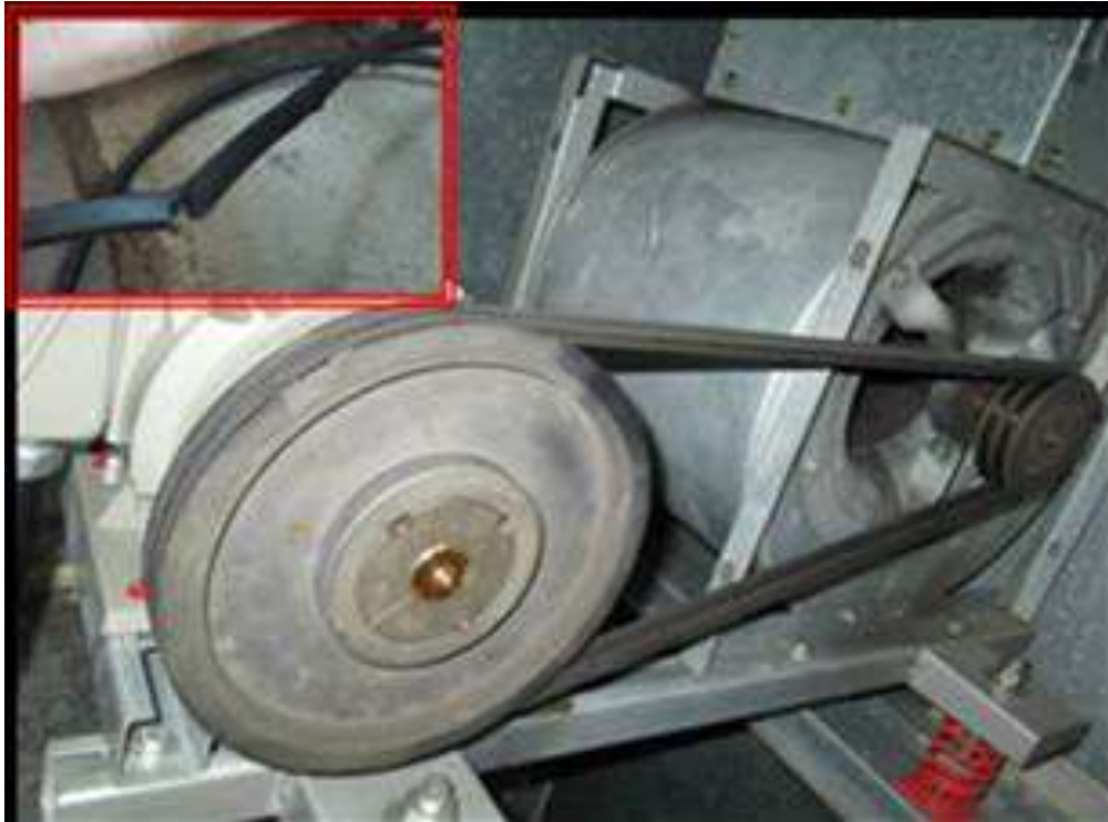
圖 34 空調箱皮帶檢查與更換
