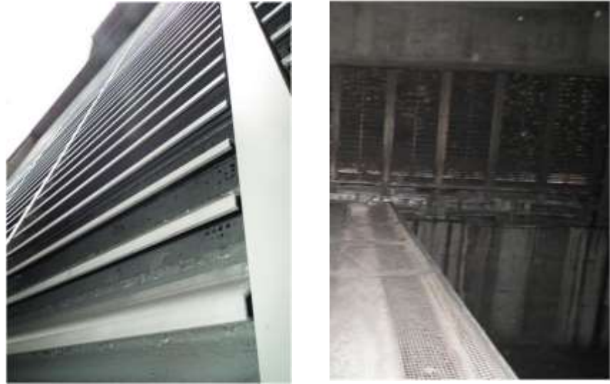
圖 29 外氣進氣口髒污與阻塞情形
