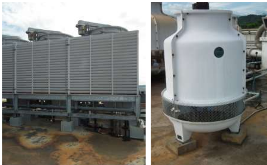
圖 22 常見冷卻水塔結構體外觀
