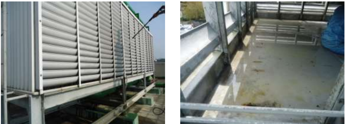
圖 30 冷卻水塔維護與清潔
