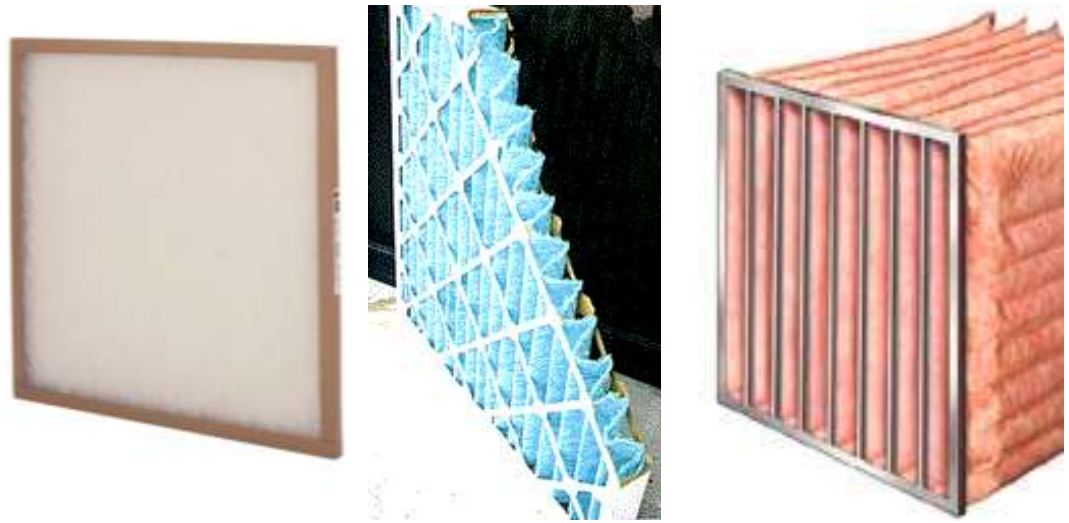
圖 8 過濾網型式示意圖
